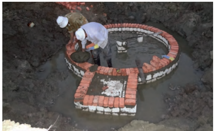
Travaux souterrains à l'unité de digestion du biogaz
