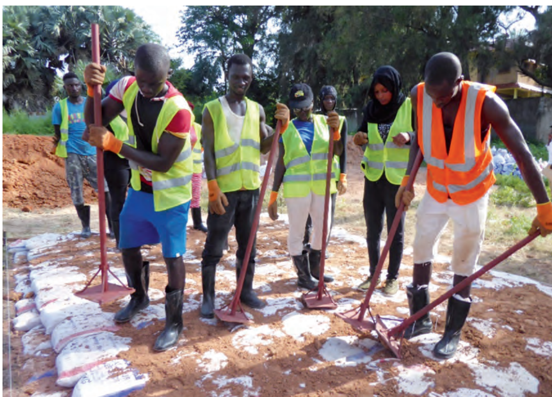
Avec l'aide du BIT, des jeunes sont formés aux techniques de travail à haute intensité de main-d'œuvre, s'ouvrant ainsi des perspectives d'emploi dans la construction
