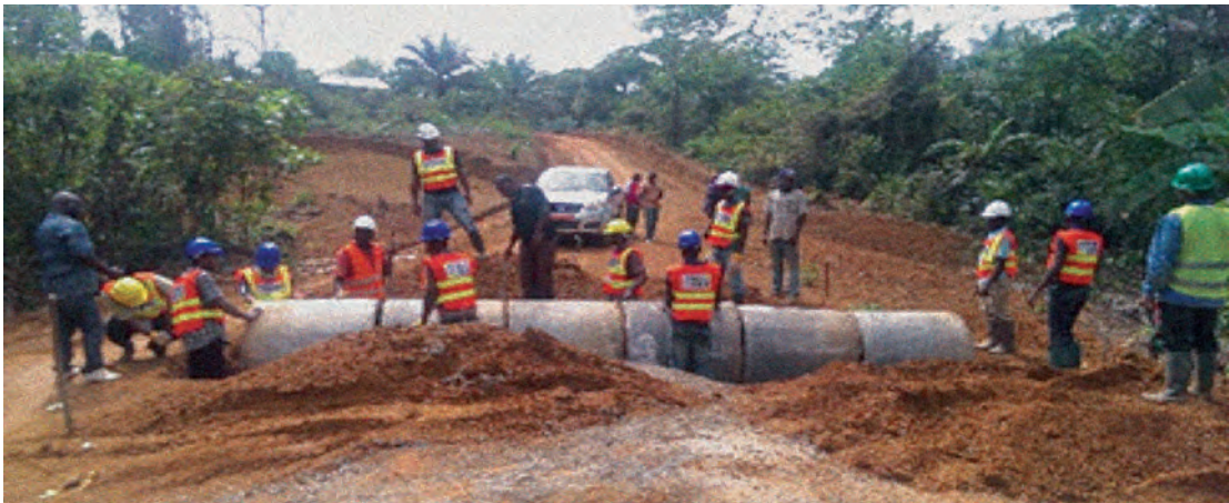
Travaux de construction de la route Kumba-Mamfe
