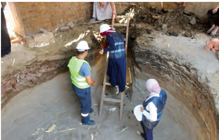
Construction d'un digesteur de biogaz
