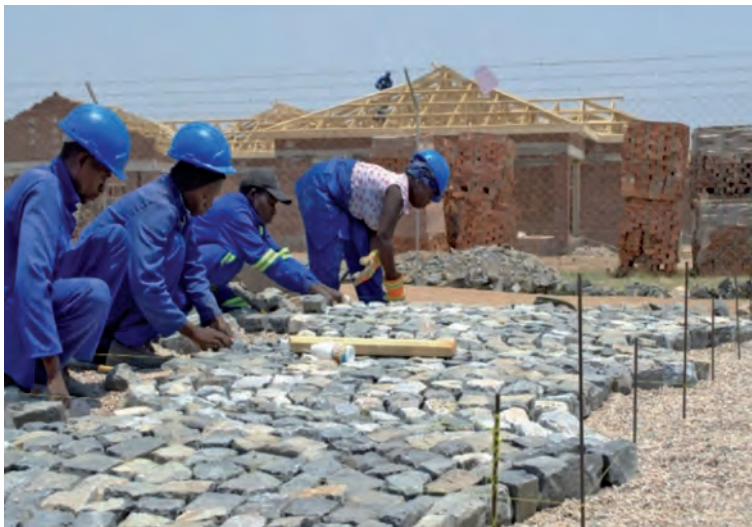
Formation sur-le-tas à la pose de pavés
