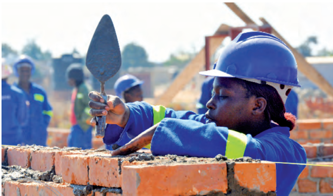
Zimbabwe: Formation sur-le-tas à la pose de briques
